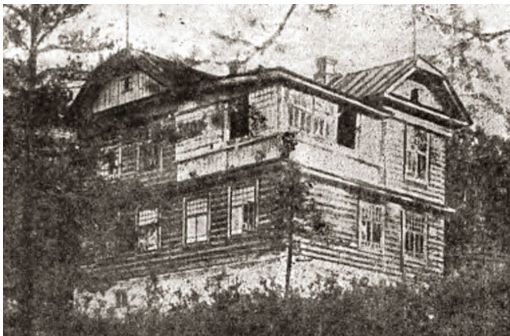
Рис. 3. Жилой дом № 2 на центральной базе заповедника с музеем на втором этаже (1932–1934 гг.). Фото 30-х г.
